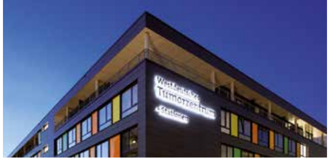
WTZ Stationsgebäude (© UK Essen)
