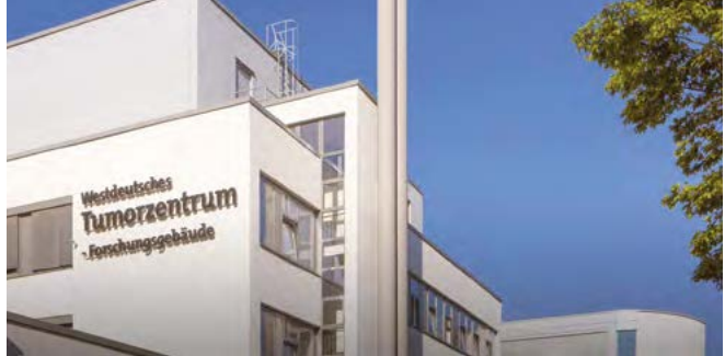
WTZ Forschungsgebäude (© Scheffler Labor)
